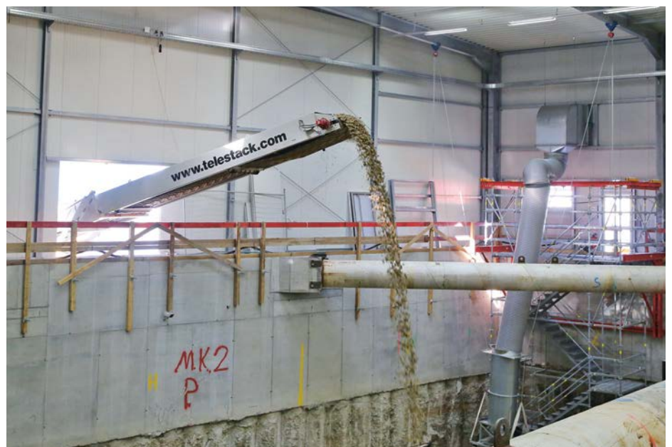
... per Förderband in das Halleninnere des komplett ausgehobenen Baufeldes Nord; Quelle: Pressefoto Roche.
