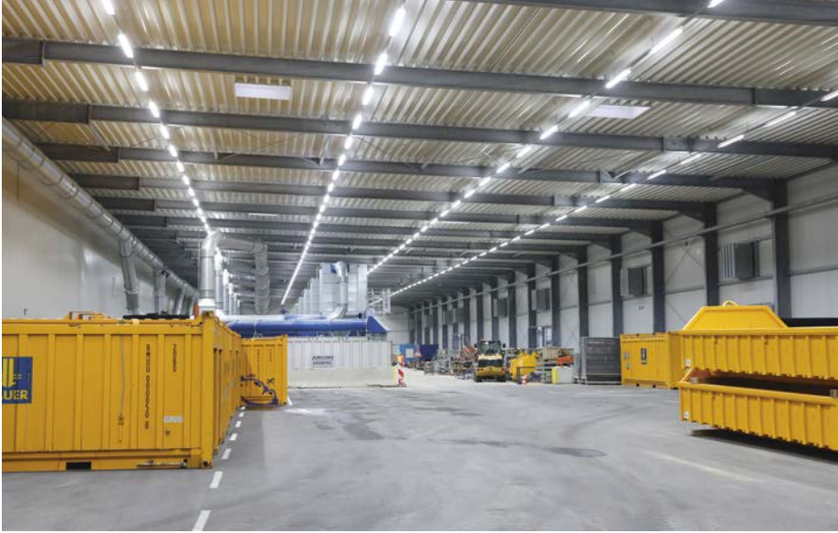
Blick in das komplett sanierte Baufeld Nord mit der Abluftreinigungsanlage; Quelle: Pressefoto Roche.
