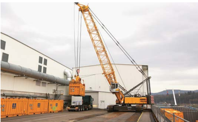
Ein Container wird per Seilkran vom LKW direkt auf das bereitstehende Schiff verladen; Quelle: Pressefoto Roche.
