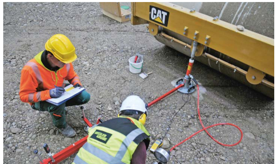
Im Rahmen der Verdichtungskontrolle wurden u. a. auch statische Plattendruckversuche durchgeführt. Die Walze diente dabei als Gegengewicht; Quelle: Pressefoto Roche.
