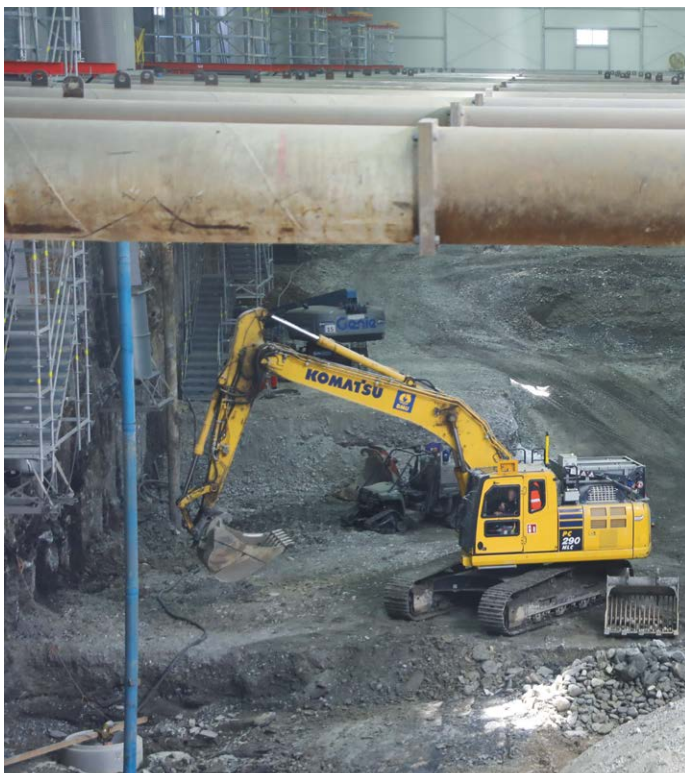
Der Aushub erfolgte wie bereits beim Baufeld Nord konventionell mit Aushubbagger; Quelle: Pressefoto Roche.
