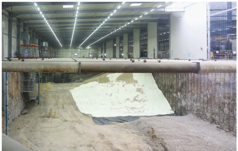
Blick in das Baufeld Süd und die neu aufgeschüttete „Weißrampe“ aus natürlichem und unbelasteten Kiesmaterial; Quelle: Pressefoto Roche.
