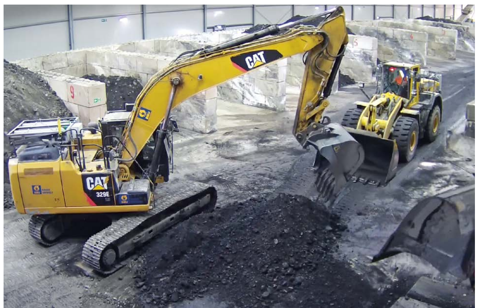
Belastetes Erdmaterial wird je nach Schadstoffbelastung sortiert, um zu den dafür geeigneten thermischen Behandlungsanlagen abtransportiert werden zu können; Quelle: Pressefoto Roche.
