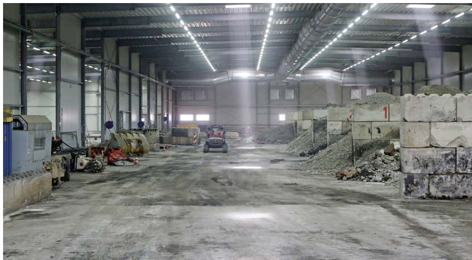
Im Rahmen der Umbauarbeiten wird die Logistikfläche mit den Lagerboxen vom Baufeld Mitte auf das Baufeld Süd umplatziert; Quelle: Pressefoto Roche.
